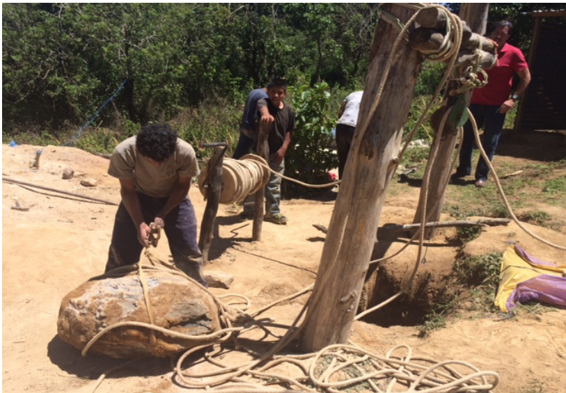
Kauf zu glauben, dass dieser riesige Stein aus über 60 Meter tiefe durch das kleine Erdloch heraus gezogen wurde. Die Grabung erfolgt durch reine Handarbeit.
